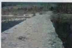
Passage à gué sur le Rizzanese avant travaux
