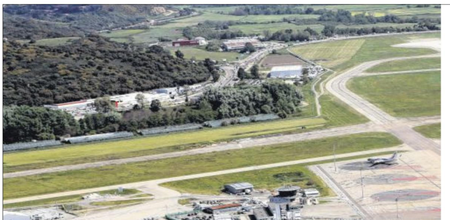
C'est le site du Prunelli (terrain Allegrini) qui devrait accueillir le centre de tri et de valorisation des déchets.
