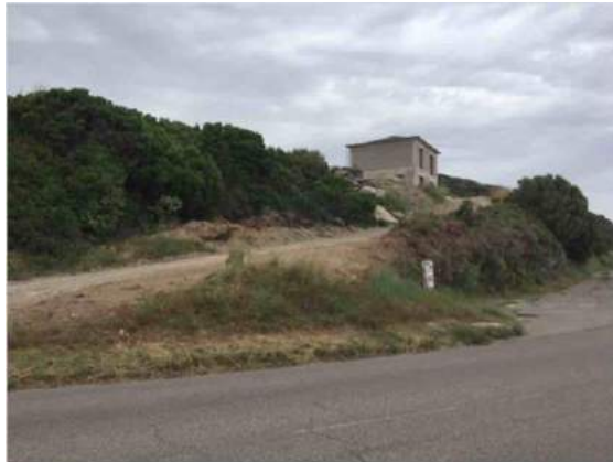
Construction photographée le 11 juin
